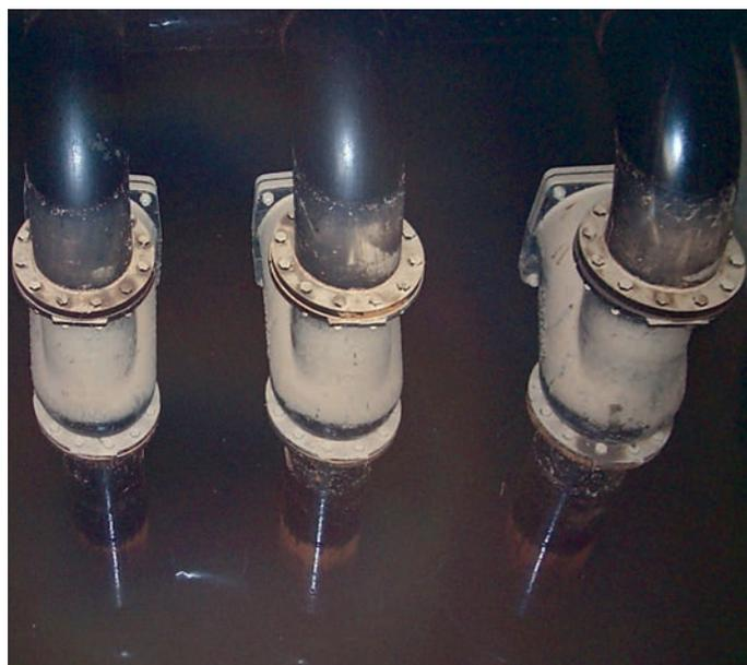
Le valvole a saracinesca a ghigliottina, con comando a volantino, ricoprono varie funzioni e vengono usate come organi di intercettazione per regolare il flusso in una tubazione o isolare temporaneamente un settore di impianto.
